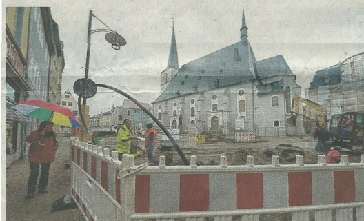
Die Stadtkirche St. Peter und Paul in Weimar, oft „Herderkirche“ genannt, weil Johann Gottfried Herder von 1776 bis 1803 dort als Oberpfarrer und erster Prediger wirkte. Die energetische Sanierung musste auch auf die wertvollen Kunstwerke in der Kirche abgestimmt sein.
