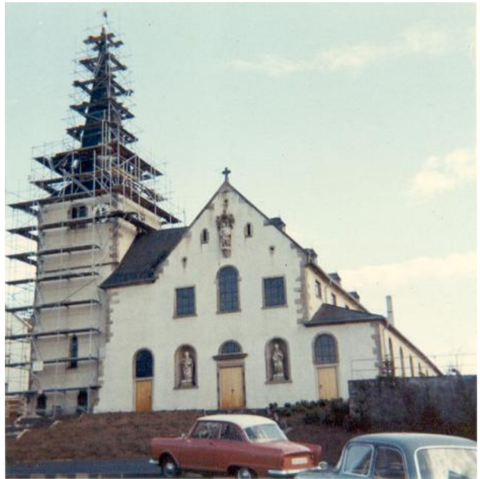
Turmreparatur nach einem benachbarten Scheunenbrand 1967
