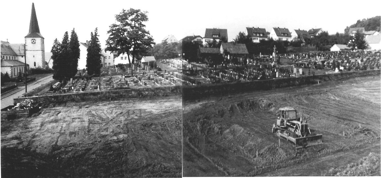
Planierungsarbeiten in 1974 für die Friedhofserweiterung
